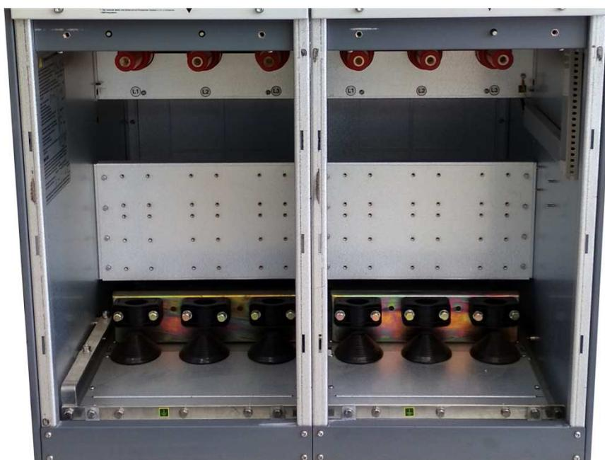
Доступ к месту подключения кабелей осуществляется с лицевой стороны шкафа, после включения заземления кабельной линии.
