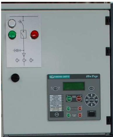
Отсек вторичных цепей располагается над отсеком высоковольтных подключений в виде отдельного металлического шкафа с дверью.
