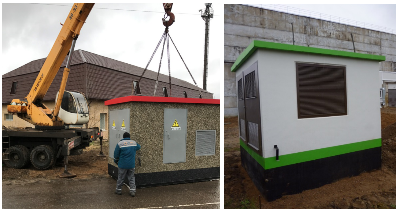
Рисунок 3. БКТПНУ в бетонной оболочке. Варианты отделки
